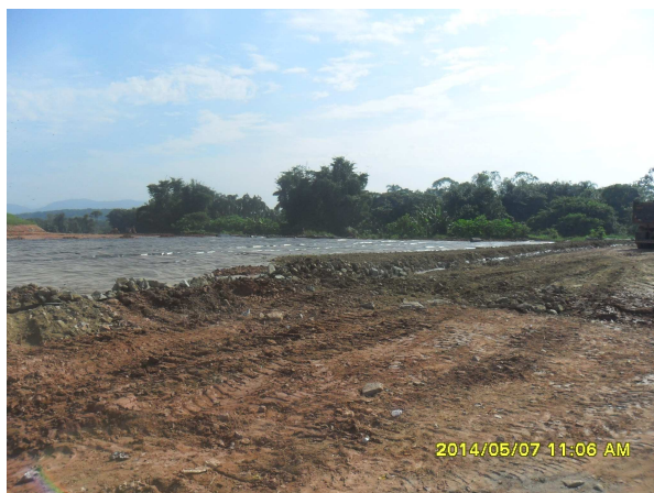
Impermeabilização de base do aterro com manta PEAD
