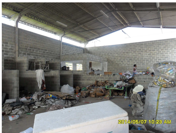
FOTO 02 – Vista interna do galpão de reciclagem
