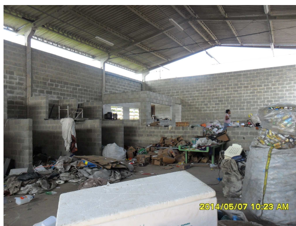
FOTO 02 – Vista interna do galpão de reciclagem
